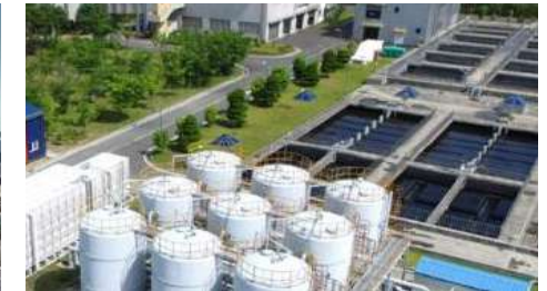
울산 석유화학단지 용암 방류수 재이용 시설
