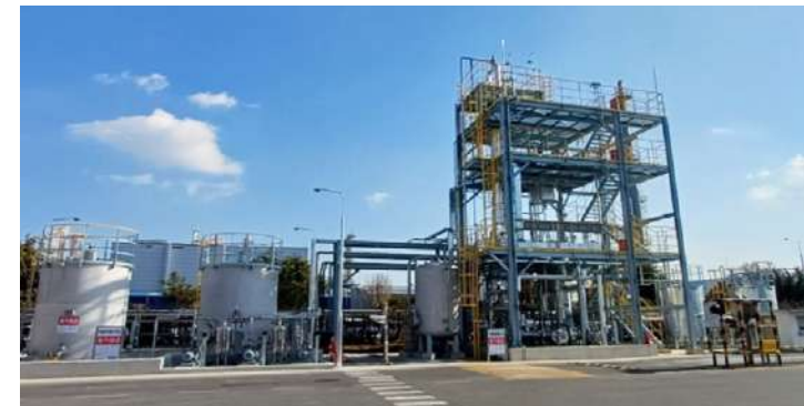
울산공장 내 재활용 EG 정제소 전경
