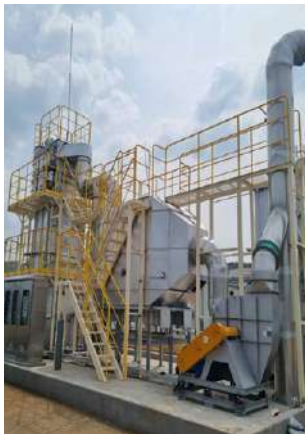
약취 방지 시설 설치
