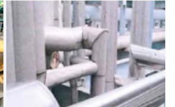
울산공장 P-5 Plant 보온재 보강
