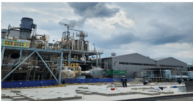
신규 RTO 설치
