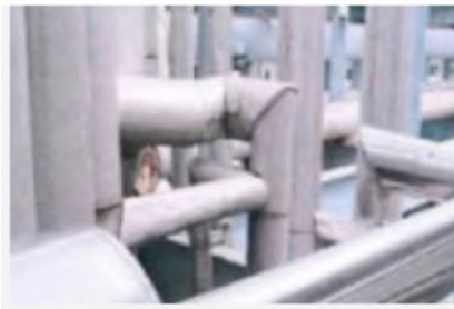
울산공장 P-5 Plant 보온재 보강
