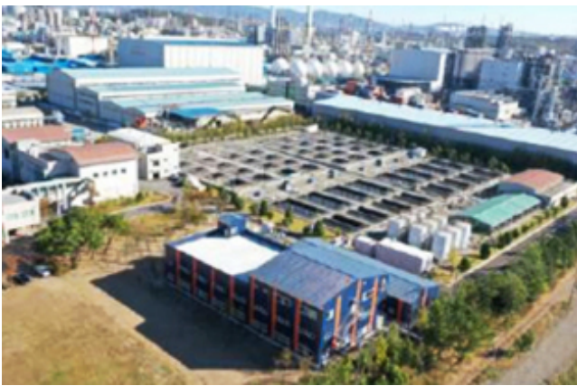
울산석유화학단지 용암 방류수 재이용 시설
