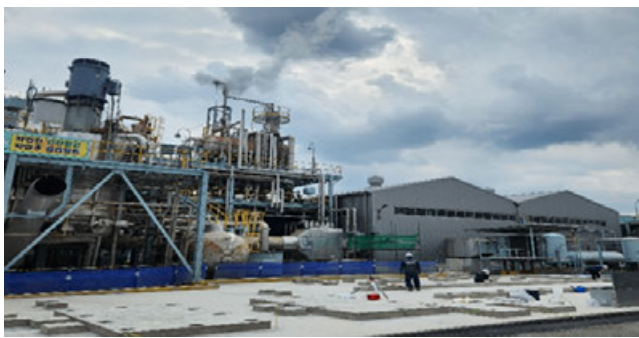
신규 RTO 설치
