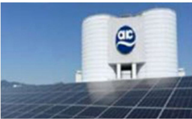
대전연구소 태양광 발전시설
