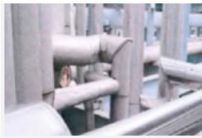
울산공장 P-5 Plant 보온재 보강
