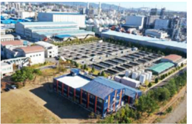
울산석유화학단지 용암 방류수 재이용 시설
